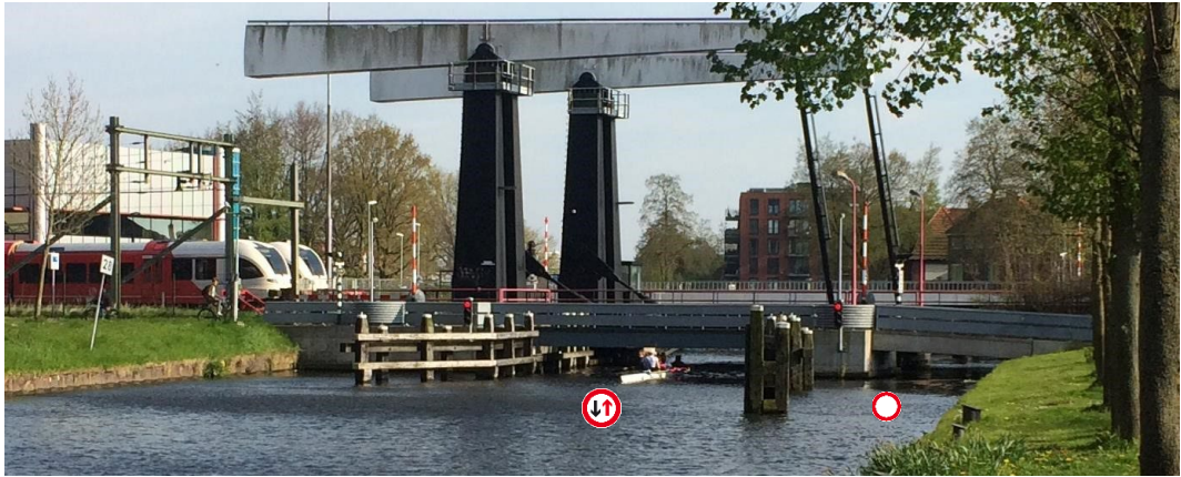
Afbeelding 8 Van Hallbrug en Spoorbrug (stad uit)
